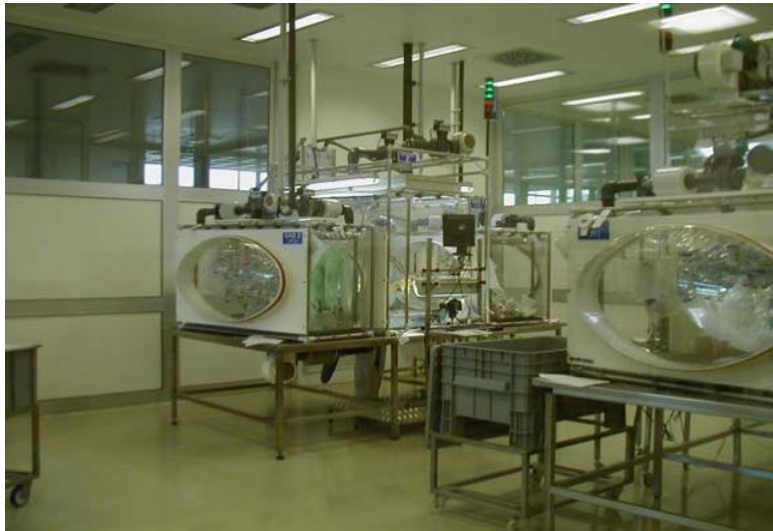
Isolatore principale a semiscafandro con SAS laterali
